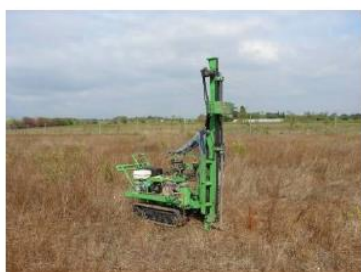
Sondage au pénétromètre
