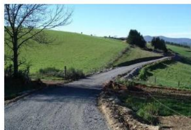
Mise en place du gravier
