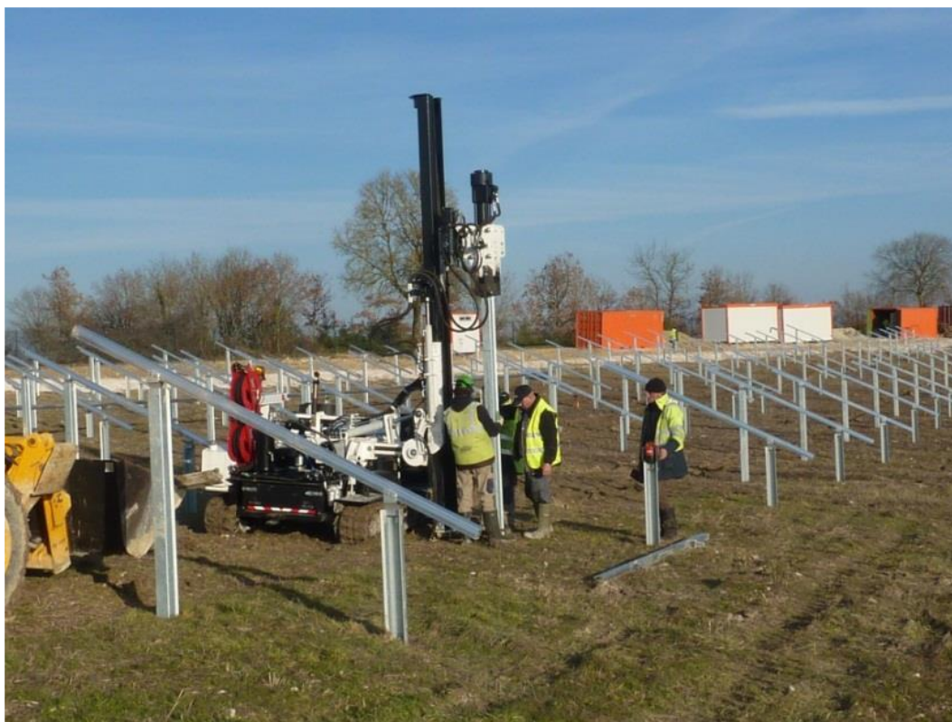
Illustration 14 : Mise en place de support de panneaux
