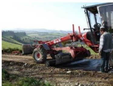
Pose du géotextile
