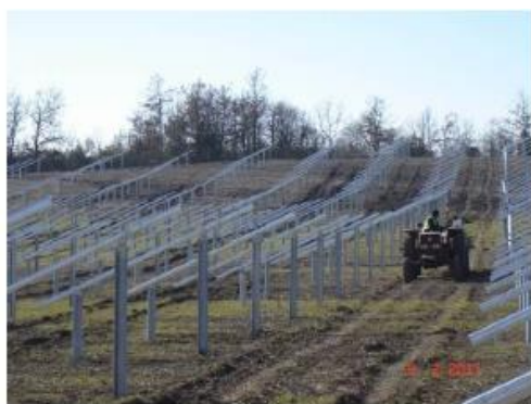
Fixation des adaptateurs
