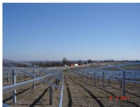
Fixation des rails de support
