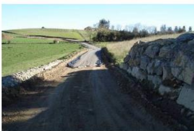
Mise en place du gravier
